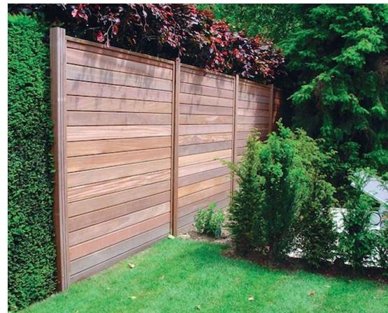
Lame d'emboîtement en bois exotique rentrant l'une sur l'autre dans 1 poteau à rainures en bois ou en aluminium.
