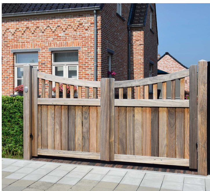
180/160 x 300 cm padouck; ici planches à tenon et mortaise
